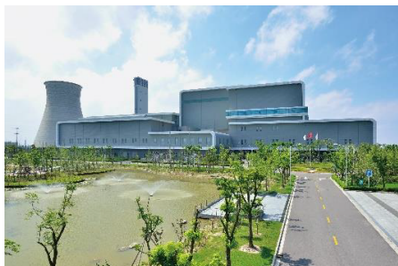
ごみ焼却発電施設
