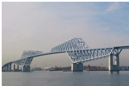
東京ゲートブリッジ
